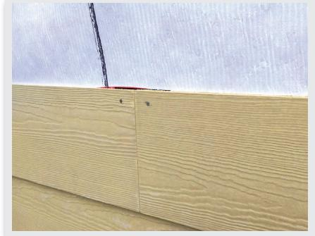
**PASO 1:** Instalar las primeras piezas del revestimiento sin clavar el terminal cerca de la junta de tope.
